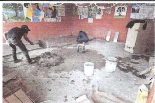
Foto 4: En la Foto se muestra como los albañiles están pegando cerámico duela en otra de las aulas.
