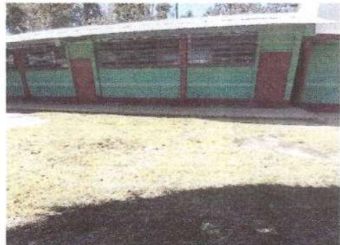
FOTO 2: Se observa el frente de 2 aulas que se están sustituyendo piso cerámico duela. Modulo 2.
