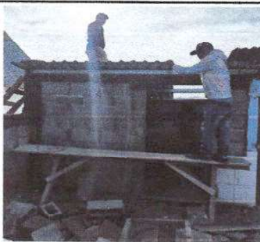
Foto 5: En la foto se observa el cambio de pared de block y lámina en la sustitución de mingitorio de concreto. .
