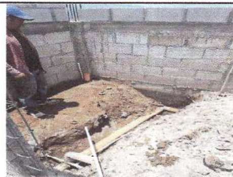
Foto 6: En la foto se observa la parte interior del mingitorio de concreto, la cual se esta remodelando la tubería de drenaje y agua potable.
